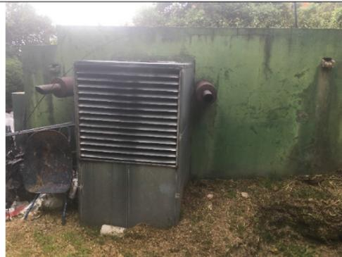
**Foto No. 4** ductos de desfogue de la planta eléctrica
